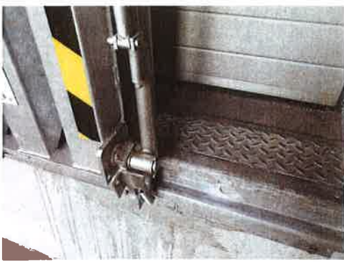
Befestigung der schwenkbaren Brücken an der Rampe.
