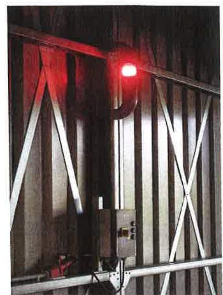
Innenansicht einer Vorsatzschleuse mit profilverstärkter Trapezblechkonstruktion.
