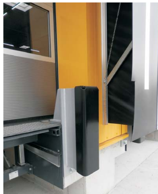
Hochbelastbare Stahlelementanfahrpuffer statt der üblichen Gummipuffer
