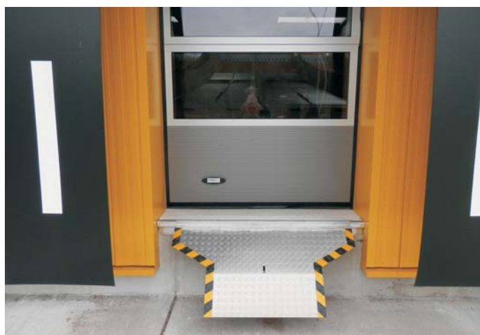
Maßgefertigte Überladebleche aus Leichtmetall erleichtern die Beladung der Lieferfahrzeuge von Deutsche Post DHL
