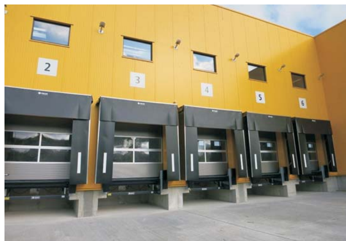
Die Paketeingangszone ist, im Gegensatz zum Ausgangsbereich, mit Standarddockstellen ausgestattet
