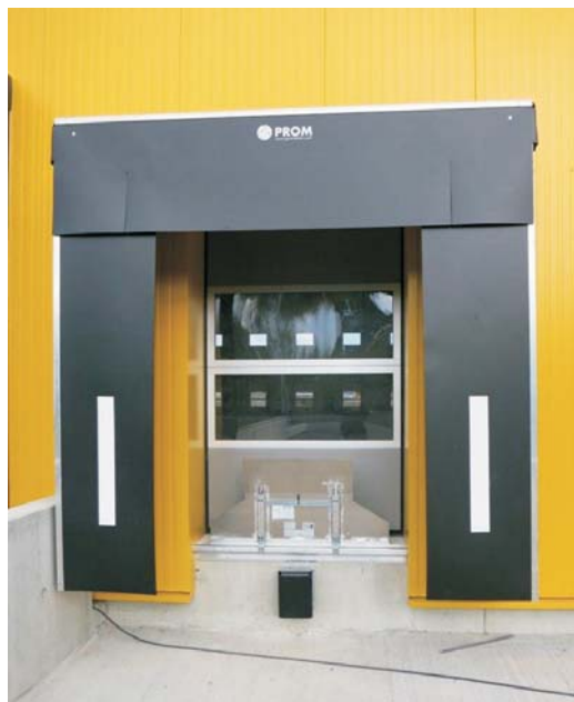
Maßgefertigte Ausgangsandruckstellen für die Beladung der Lieferfahrzeuge
