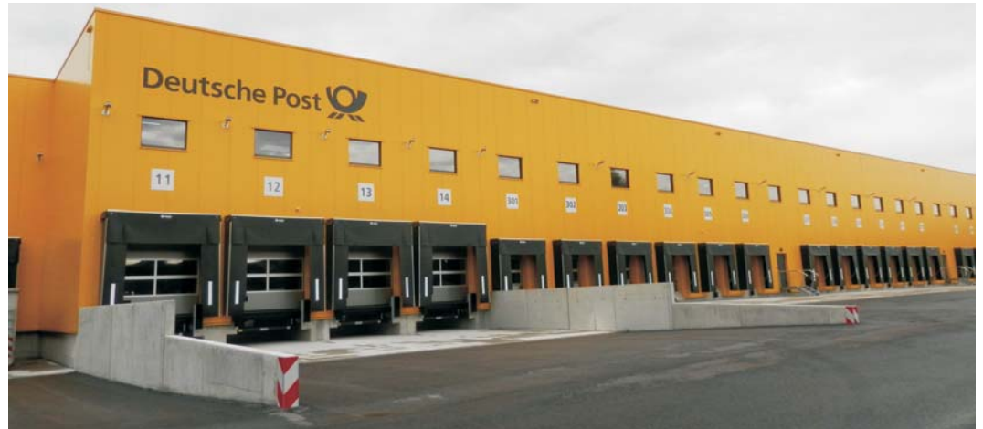
Komplettanlage der Zustellbasis Unterschleißheim von Deutsche Post DHL mit unterschiedlichen Eingangs- und Ausgangsrampen. Es gibt 48 Andockstellen für die Lieferfahrzeuge
