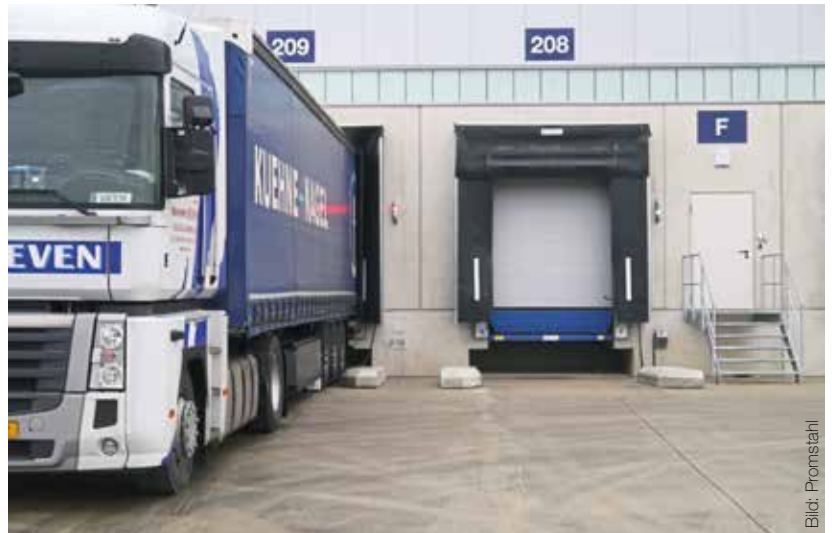
Promstahl-Verladestellen mit Überladebrücken, Torabdichtungen, Toren und Lkw-Einfahrhilfen.
