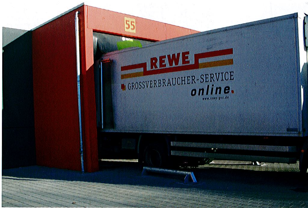
Die Verladeschleusen am Distributionszentrum von Rewe in Ulm.
